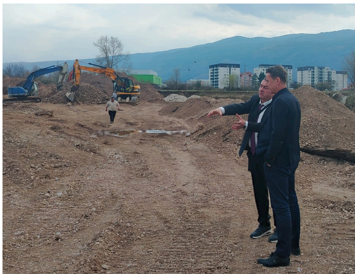
Obilazak gradilišta u Otesu
