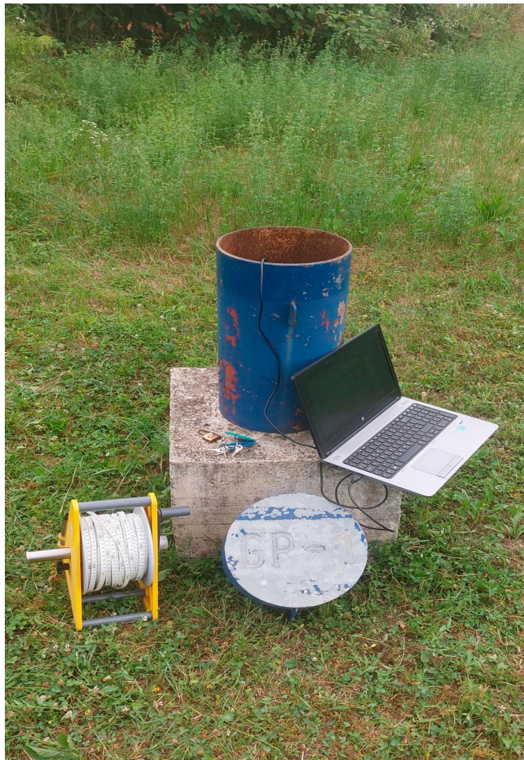
Slika 12. Pijezometarska stanica Gradačac
