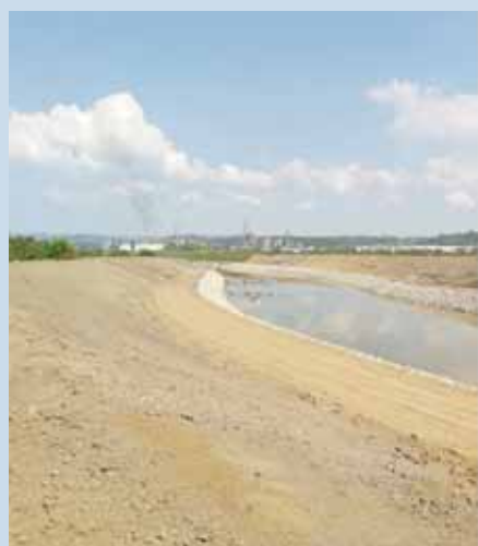
Lukavac-izvedena regulacija Spreče na dionici I
