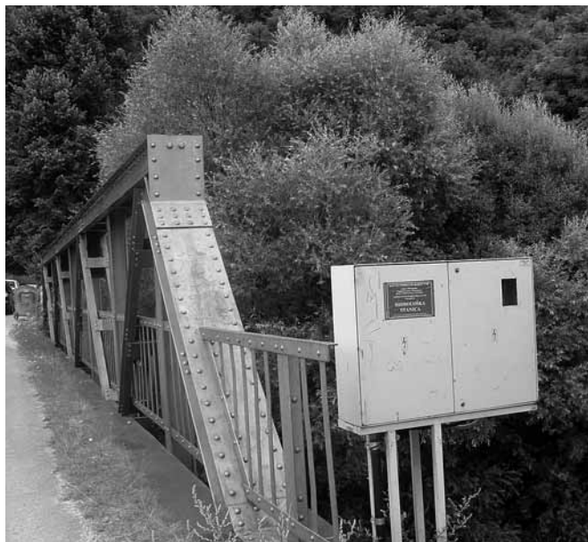
Jedna od mnogih hidroloških stanica na našim rijekama – Unac
