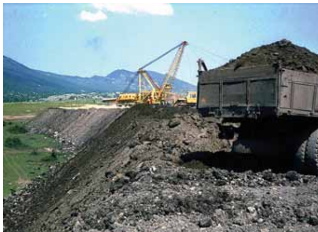
Slika 2: Gacko – Deponija krovinskog (jalovinskog) materijala koji je odložen po poljoprivrednim površinama, što dovodi do daljih oštećenja tla
