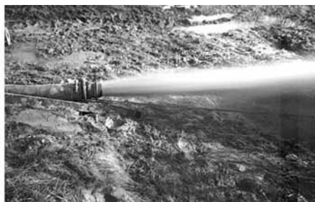
Čišćenje otvorenim air-liftom do potpunog izbistrenja vode
