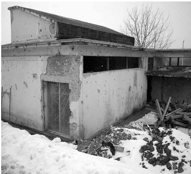
Slika br. 15 Crpna stanica - Đurići, radovi na sanaciji započeti 2005. godine
