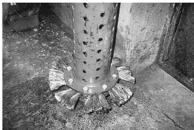
Čelična četka postavljena na sektorski air-lift
