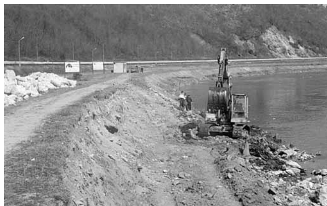
Slika br. 14 R.Bosna - Maglaj, radovi na sanaciji obloge u toku - mart 2003. godine
