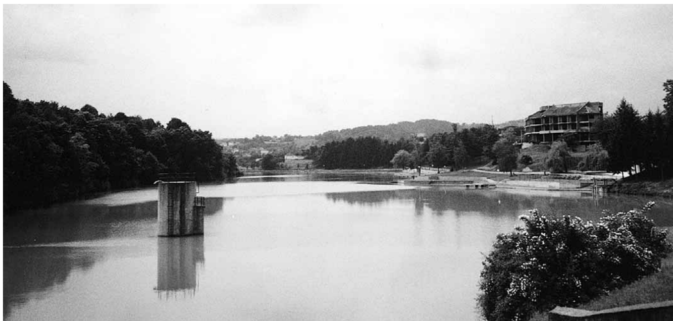
Akumulacija Hazna u Gradačcu
