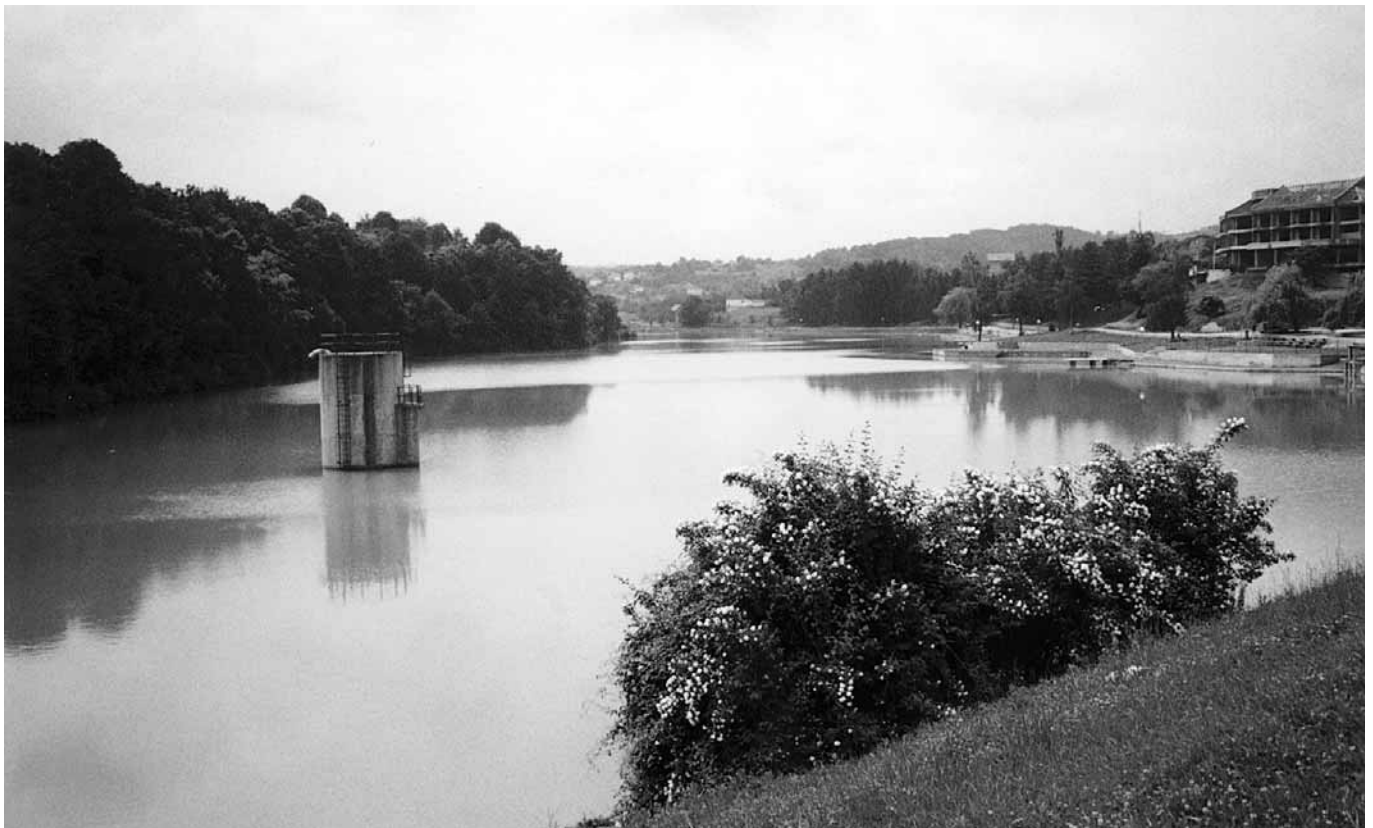
Akumulacija Hazna u Gradačcu
