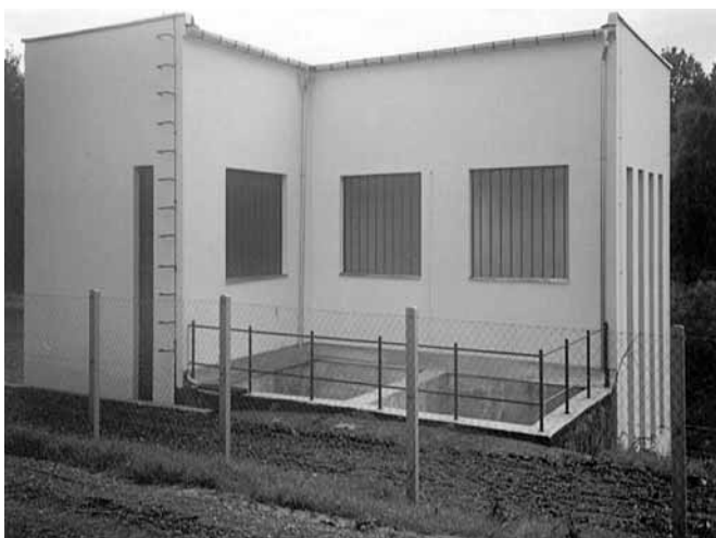
Slika br. 11 Crpna stanica Svilaj - nakon rekonstrukcije
