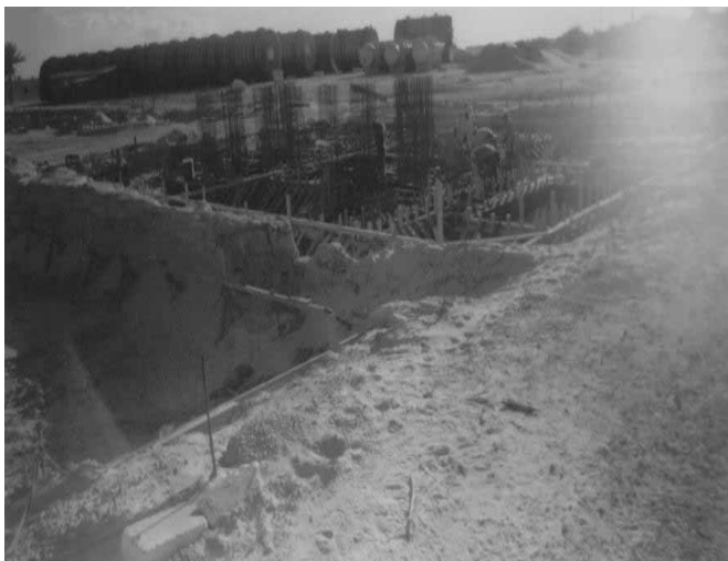
Slika 15. Zuara – Libija, izgradnja postrojenja za desalinizaciju (15-07-2004. godine)
