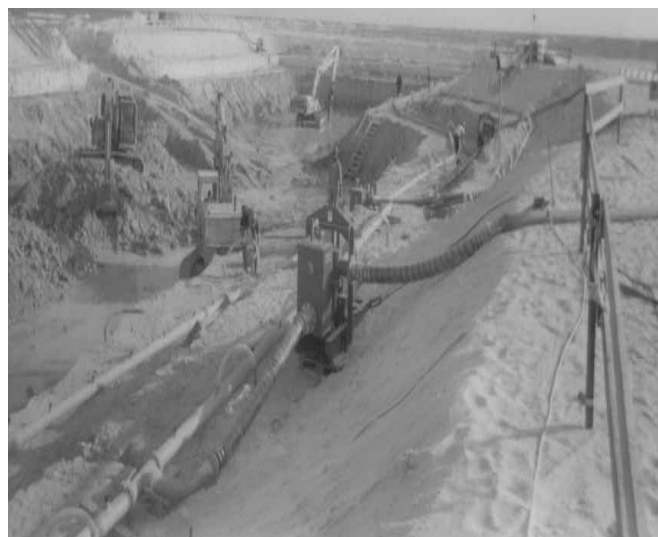
Slika 13. Zuara–Libija, izgradnja postrojenja za desalinizaciju (15-07-2004. godine)
