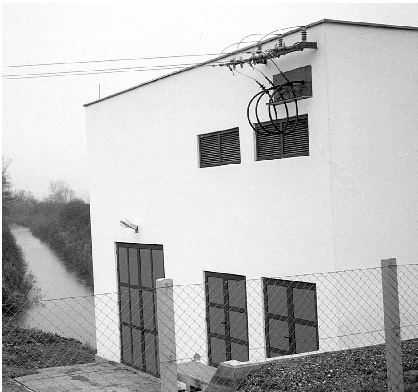
Obnovljena crpna stanica "Svilaj" na rijeci Savi ponovo u funkciji
