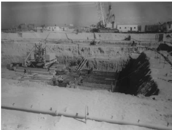
Slika 14. Zuara–Libija, izgradnja postrojenja za desalinizaciju (15-07-2004. godine)
